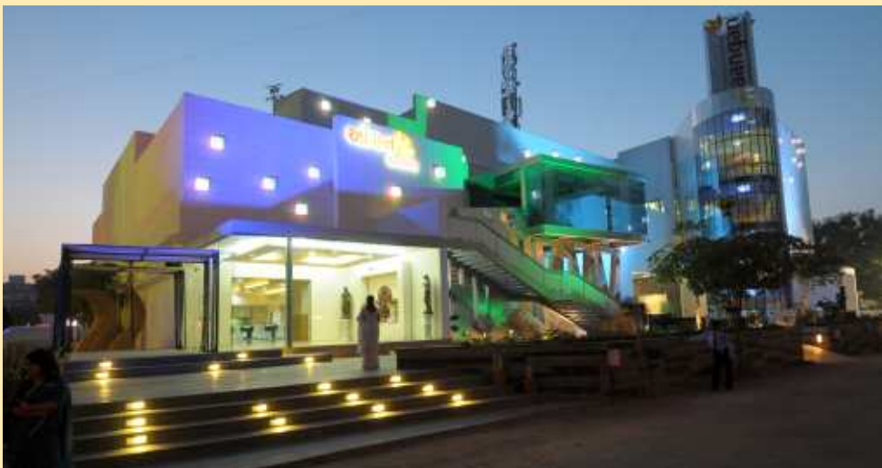
Aangan Banquet Hall, Ahmedabad.
